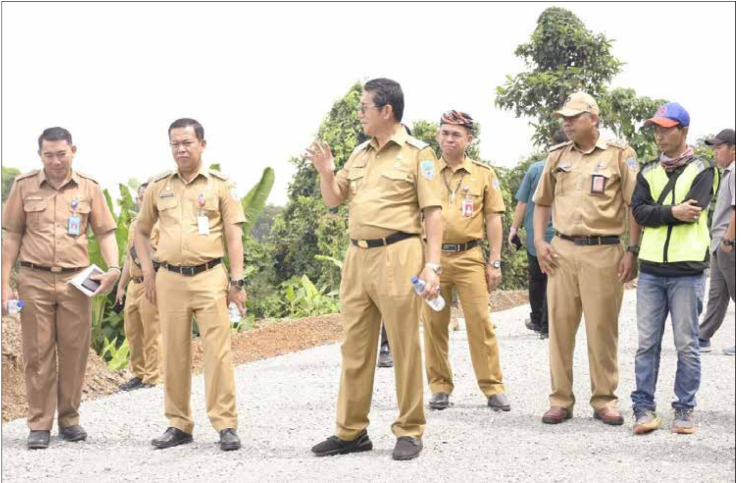
MONITORING: Wagub Kaltara, Dr Yansen TP, M.Si melakukan monev penanganan Long Segmen Kondisi Ruas Jalan Ring Road Malinau, Senin (4/9).
