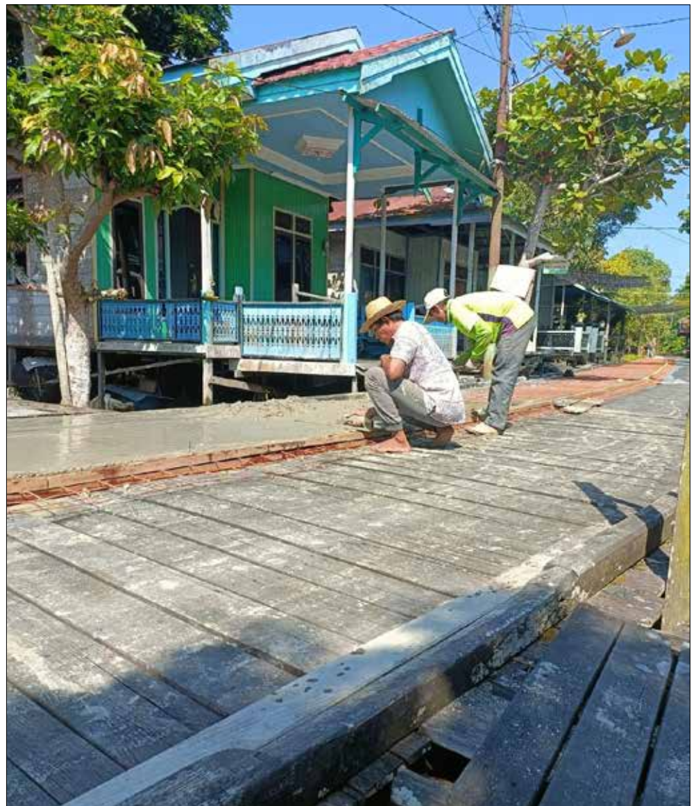
Peningkatan jalan dan jembatan di Kecamatan Muara Muntai.
